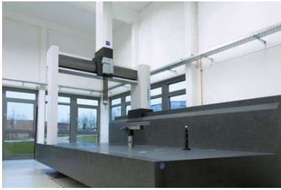
ZEISS Messzentrum ACCURA II (3D - Koordinatenmessmaschine) in voll klimatisiertem Raum
